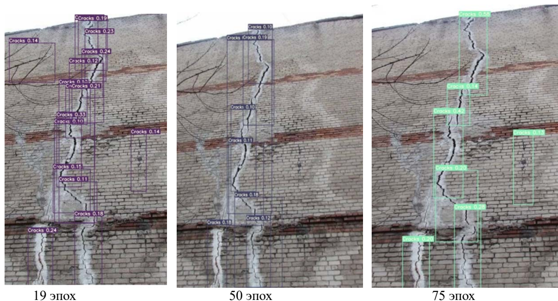
Рис. 4. Примеры распознавания дефектов с использованием сверточной нейронной сети с различным количеством эпох обучения (иллюстрация авторов)
